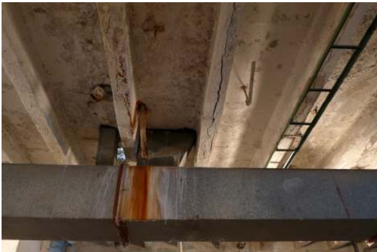
Poškodený rebrový strop vplyvom zatekania.
