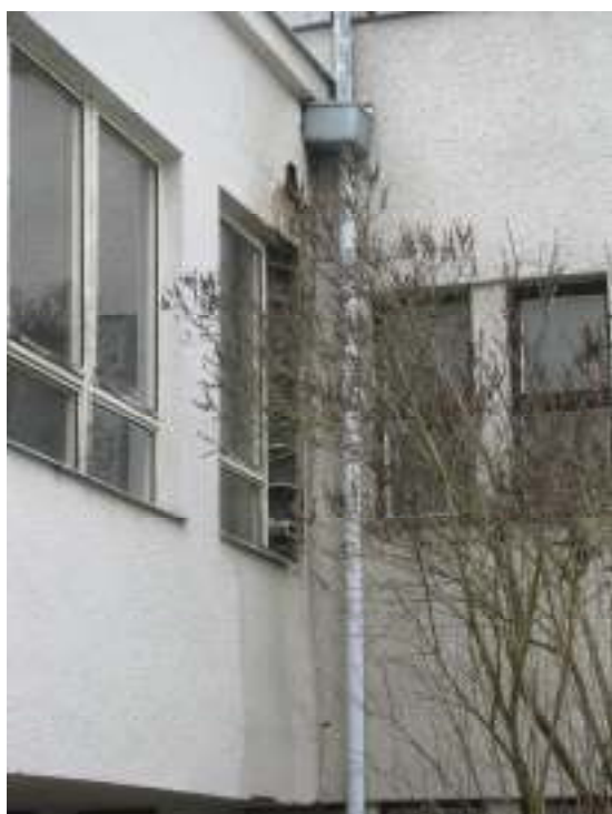
Poškodené dažďové zvody.
