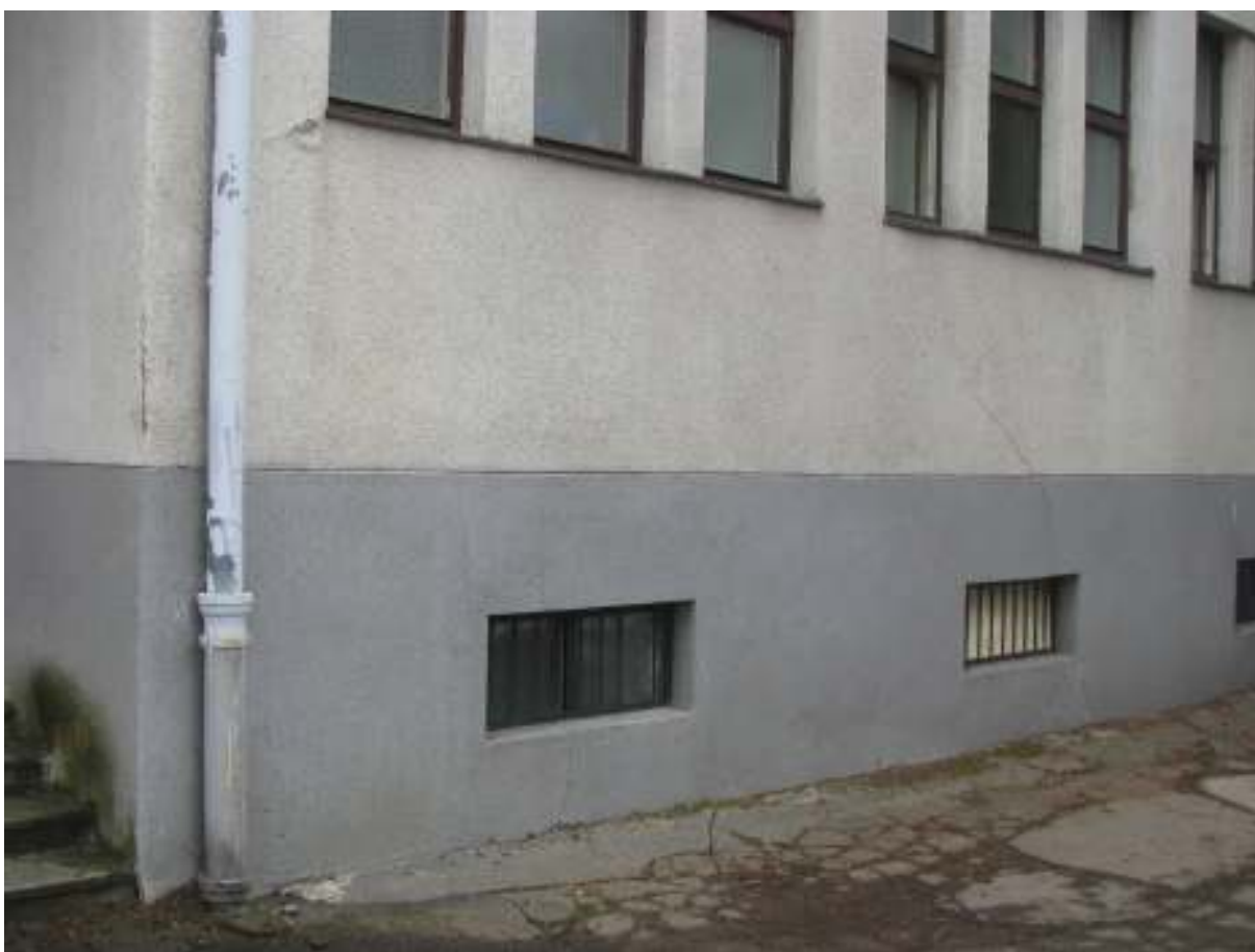
Prasknutá obvodová stena - vplyvom dosadnutia.
