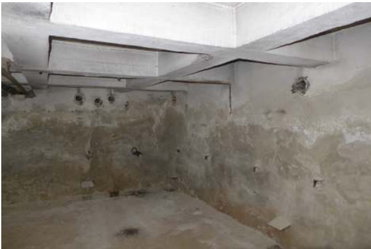
Steny pod úrovňou terénu miestami poškodenú vodou.
